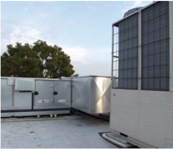
Am Dach sind insgesamt fünf Außeneinheiten der Mitsubishi Heavy Industries VRF-Anlage von Sparer Klimatechnik und drei Wolf Lüftungsanlagen (KG Top) situiert. Kleines Bild: Hinter dieser Box befindet sich eines der drei Expansionsventile.
