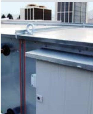
Am Dach sind insgesamt fünf Außeneinheiten der Mitsubishi Heavy Industries VRF-Anlage von Sparer Klimatechnik und drei Wolf Lüftungsanlagen (KG Top) situiert. Kleines Bild: Hinter dieser Box befindet sich eines der drei Expansionsventile.
